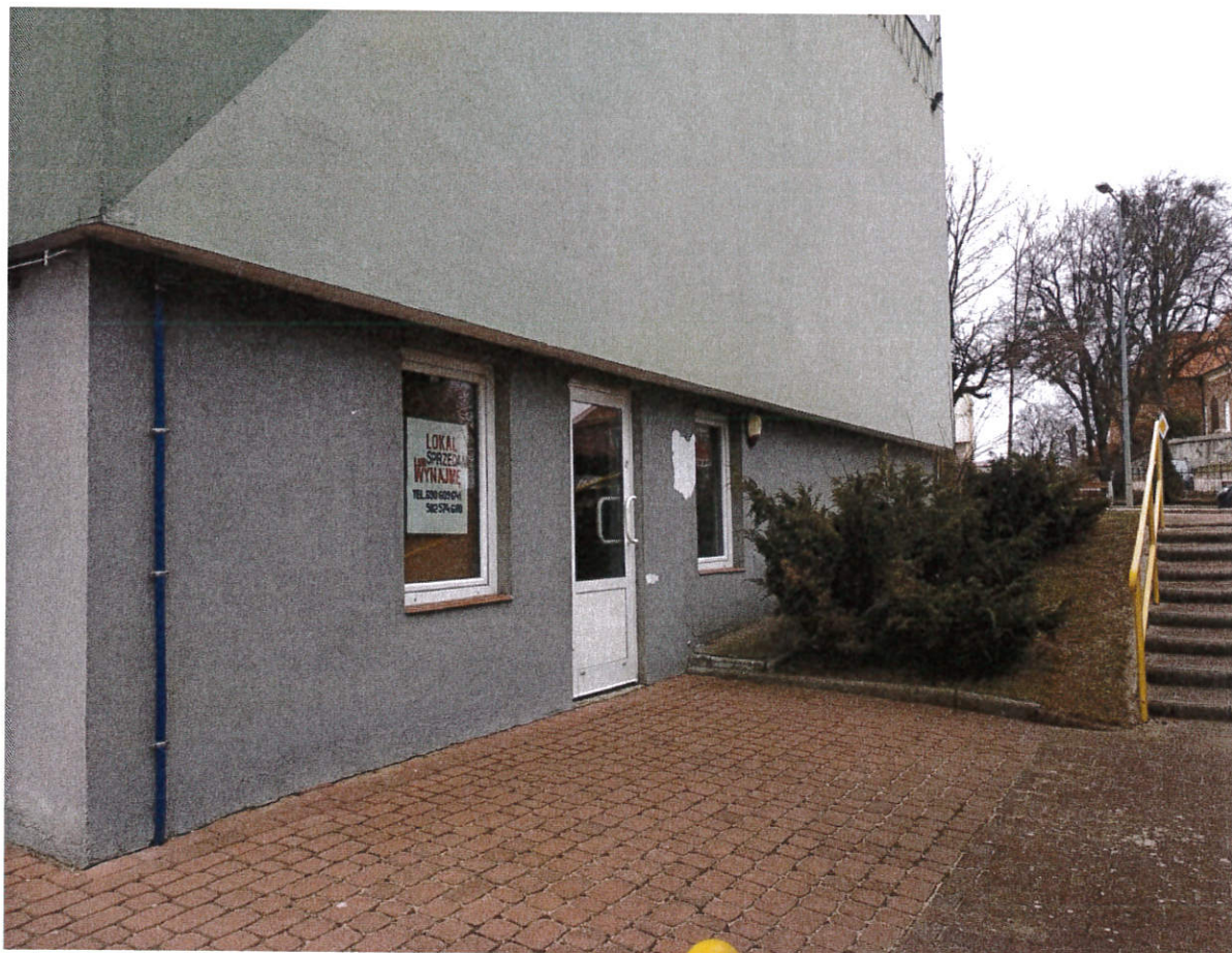
Zdjęcie nr 19 – Wykonanie nowego tynku na cokole ściany szczytowej
